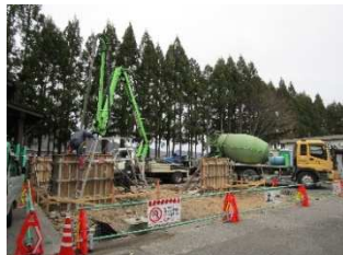
工事中のチェーンソー訓練施設
