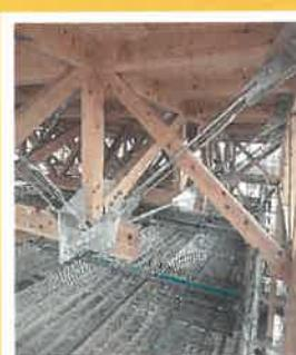
県産木材と鉄骨を使ったハイブリッド構造を採用し、木材の弱点を鉄骨で補う形で、県内で一般流通している木材の使用が可能となりました。
